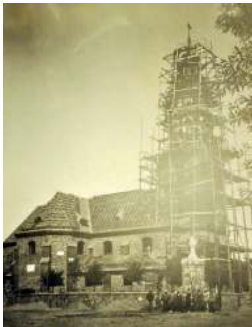
Zdjęcie wykonane podczas budowy kościoła w Skórzewie – w środku ks. St. Kozierowski – fot. AAP, Akta parafii Skórzewo, sygn. 296/9.
