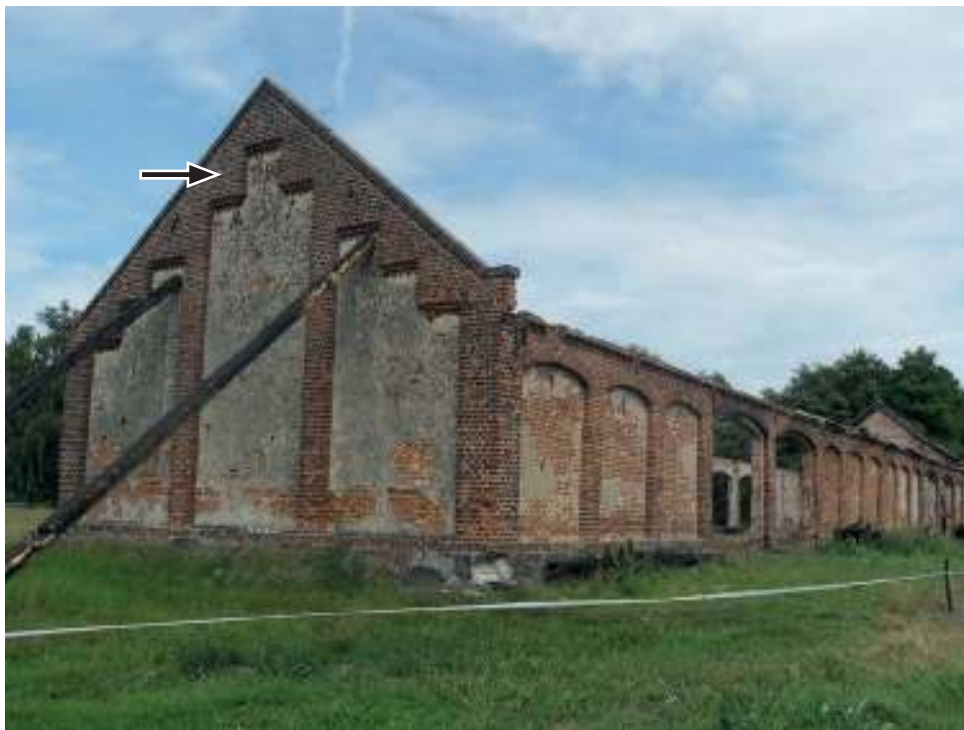
Stodoła z 1907 roku (spalona w 2013 roku, data na szczycie) – fot. archiwum autora
