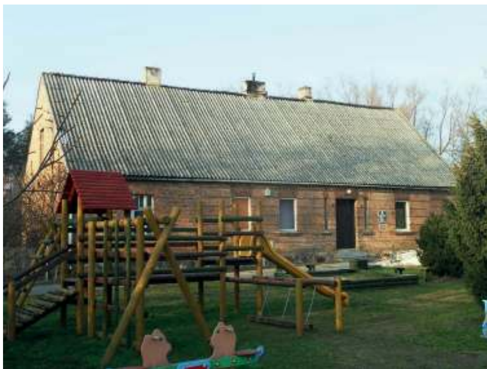
Budynek starej szkoły w Gołuskach – fot. archiwum autora
