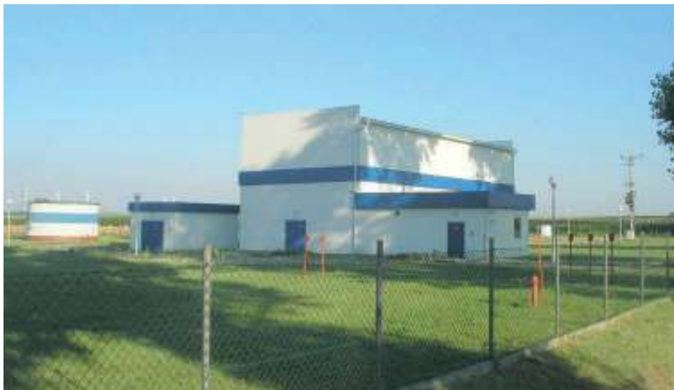
Stacja ujęcia i uzdatniania wody w Joance – fot. archiwum autora
