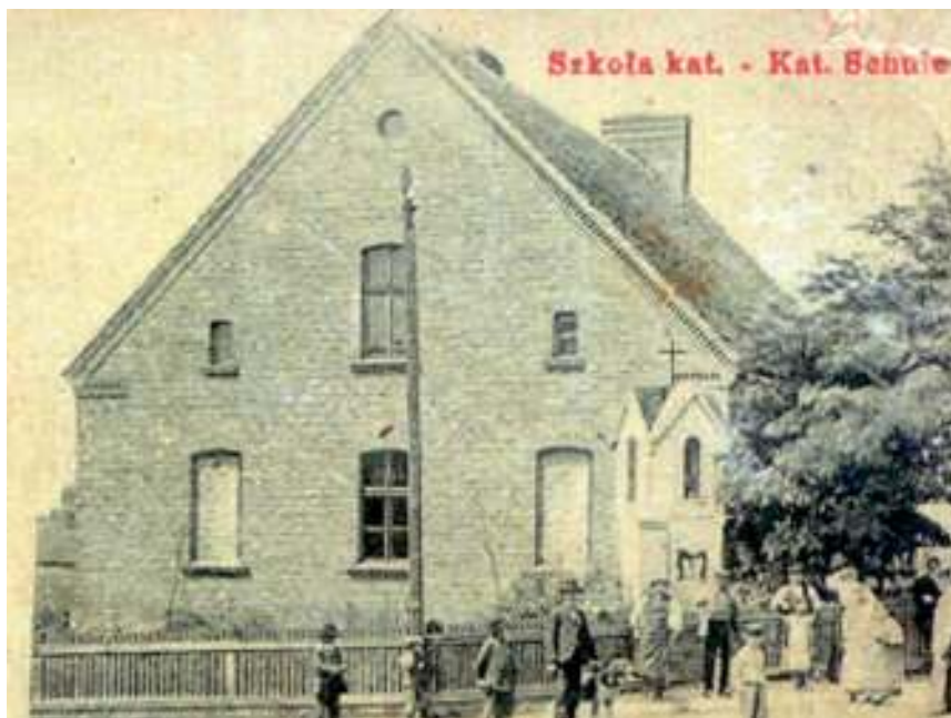
Budynek starej szkoły z lat dwudziestych XX w. przebudowany na kościół – fot. ze zbiorów E. Tomkowiaka z Dopiewa
