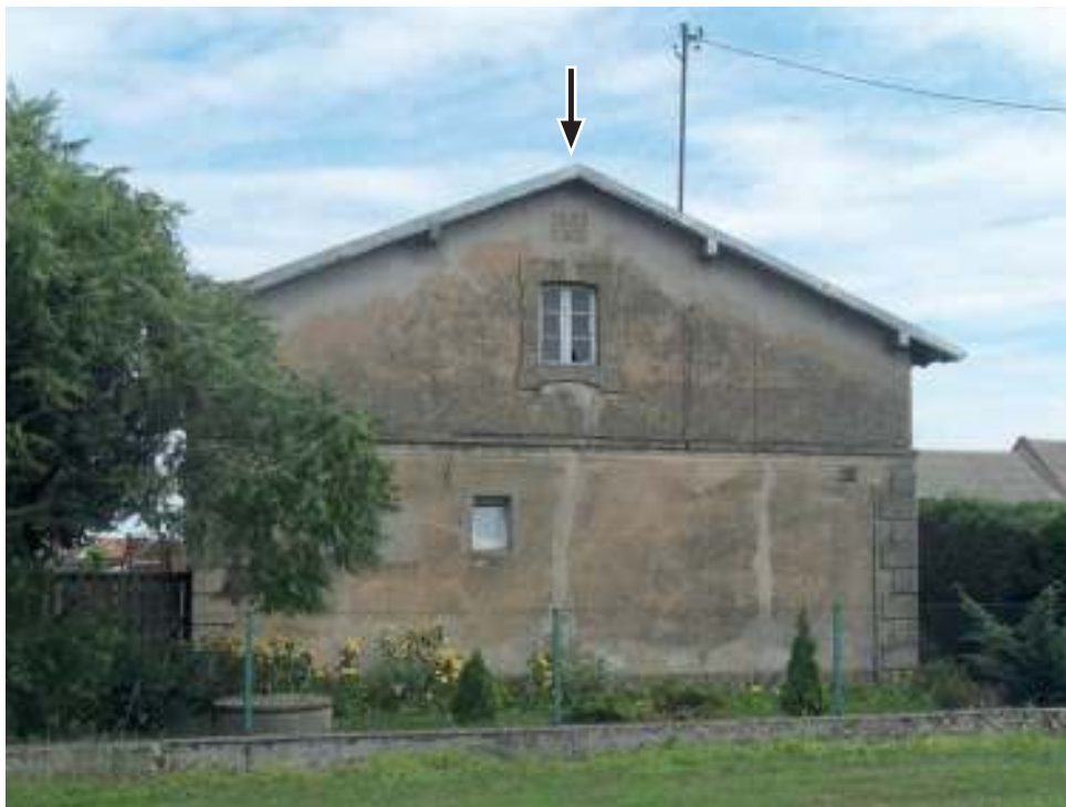
Dom z początku lat 20. XX wieku (data nad górnym oknem) – fot. archiwum autora
