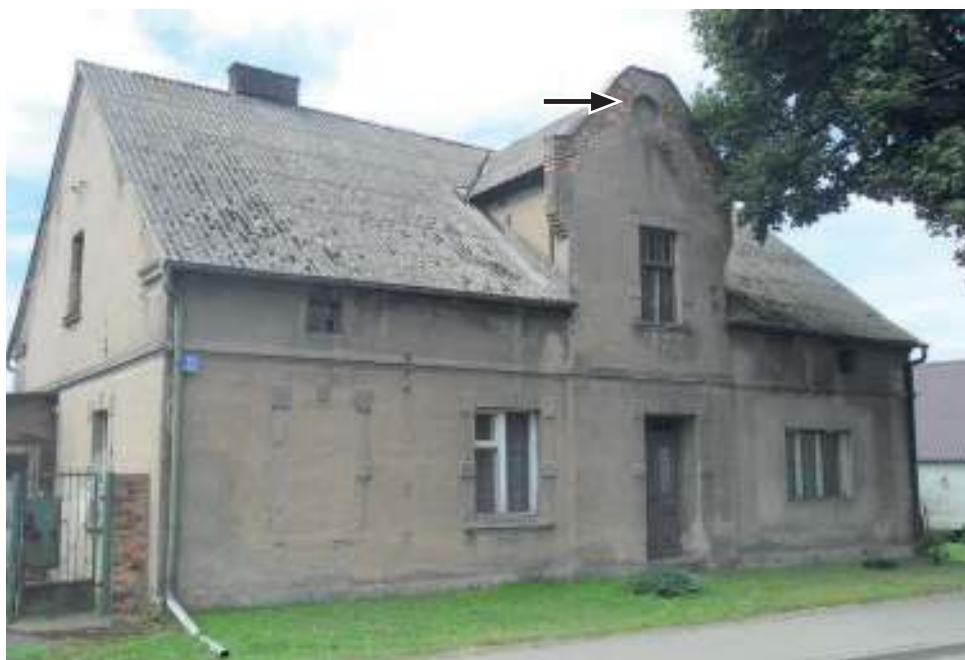
Dom z 1912 roku (data na szczycie nad oknem) – fot. archiwum autora
