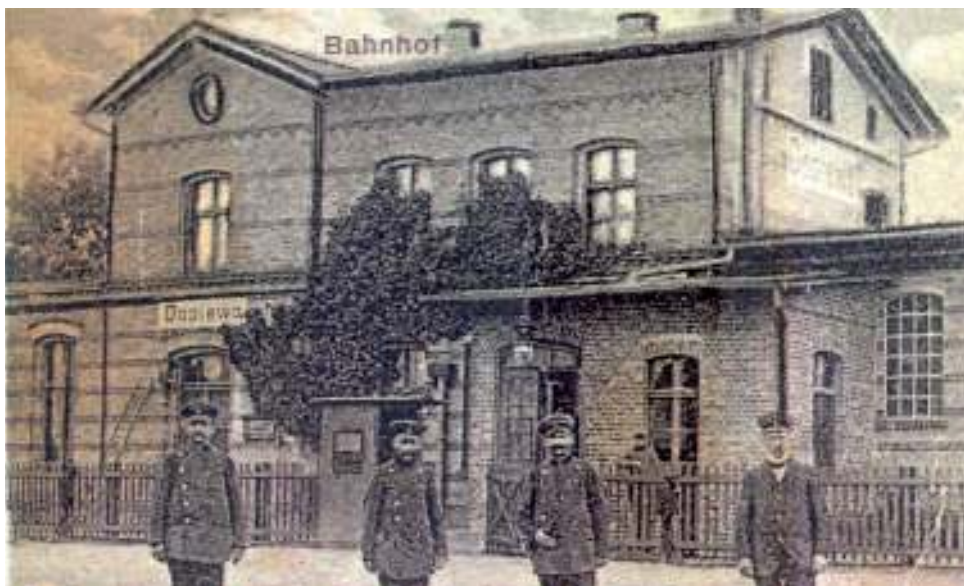
Budynek dworca kolejowego w Dopiewie zdjęcie z początku XX w. – fot. ze zbiorów E. Tomkowiaka z Dopiewa
