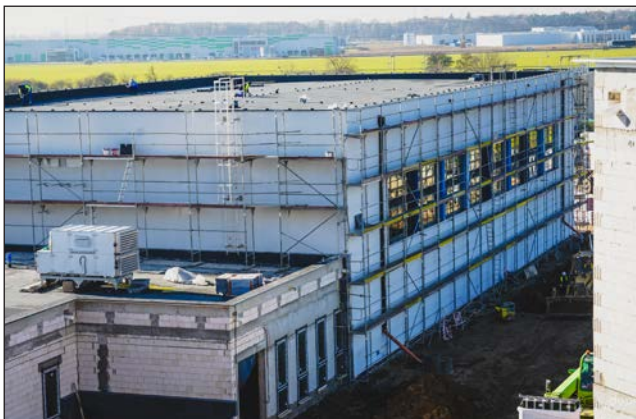
Budowa obiektu planowo zakończyć ma się w maju 2026 roku fot. Zuzanna Kaczmarek
