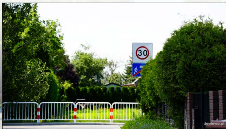
Podczas inwestycji nie tylko wybudowano ulice, ale też kanalizację deszczową oraz chodniki. fot. Zuzanna Kaczmarek
