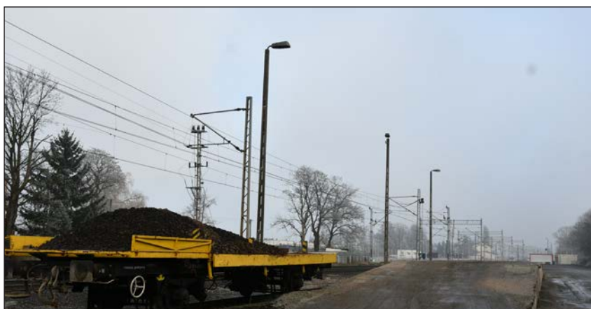
Rampa przeładunkowa fot. Zuzanna Kaczmarek
