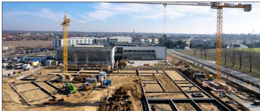
W nowych budynkach szkoły zaplanowano miejsce dla 600 uczniów fot. Wojciech Wrazowski
