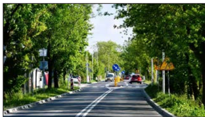
Remont ul. Poznańskiej trwa od lipca ubiegłego roku fot. Zuzanna Kaczmarek
