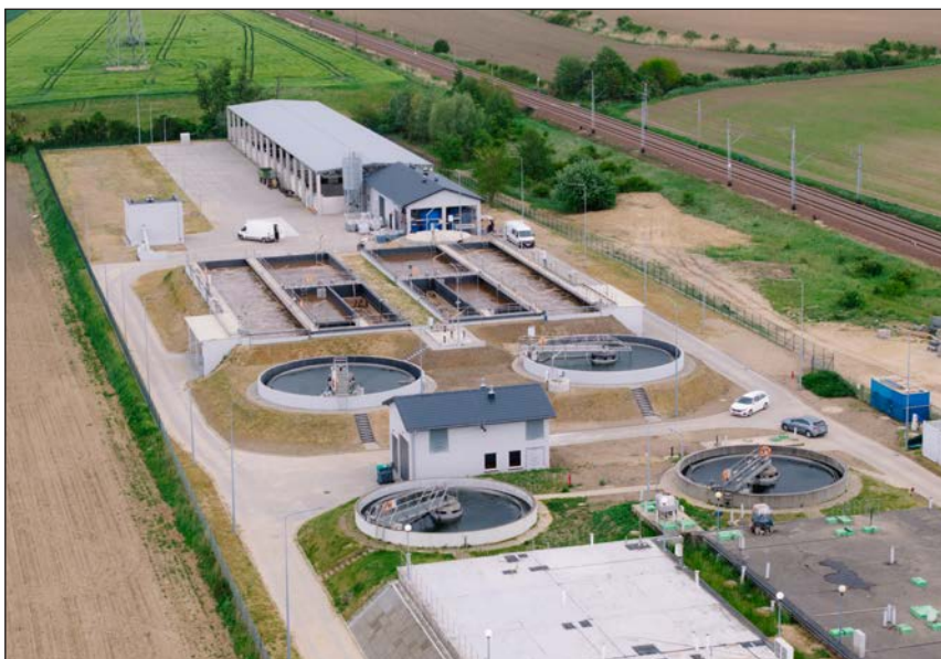
Prace nad rozbudową oczyszczalni trwały od 2022 roku fot. MIKO-Tech
